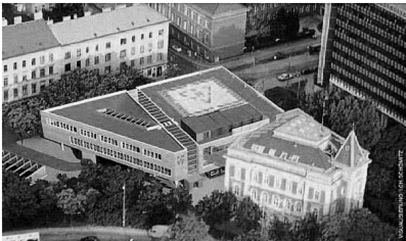
Slika 1: Stara in nova stavba službe NMP mesta Dunaj
